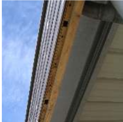
Cavités pour chauves-souris aménagées derrière un bardage en bois
