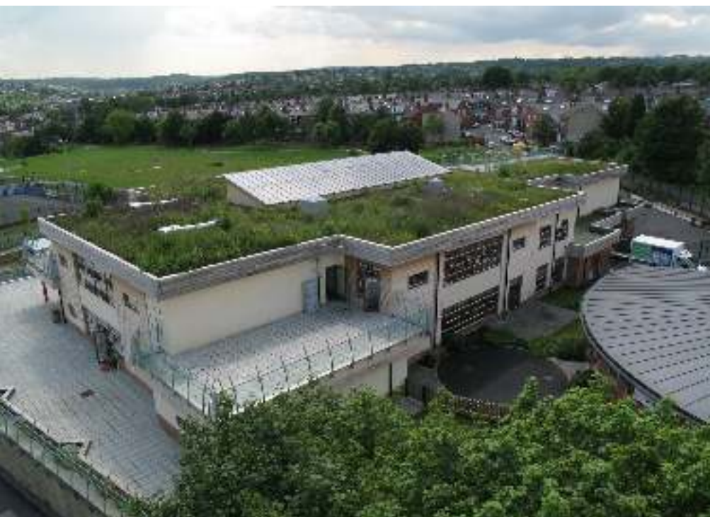
Toiture labellisée "Biodiversité"
