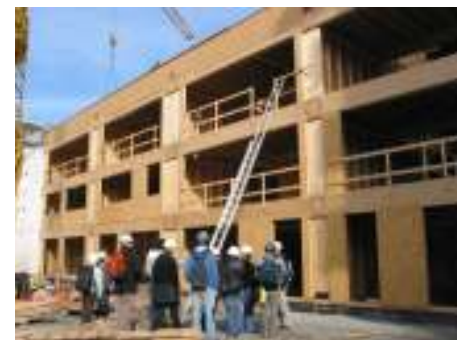
Le développement d'une filière "bois" locale a permis la construction d'un projet d'immeuble à ossature bois.
