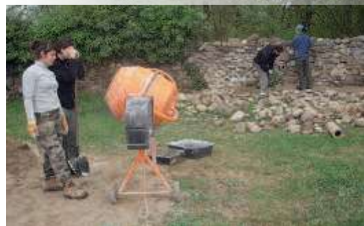
Chantier pédagogique de restauration d'un muret
